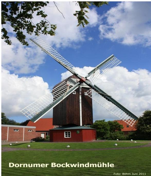
Das kastenförmige Gebäude ruht drehbar auf einem **Bock**, der aus einem senkrechten **Hausbaum**, dem **Grundkreuz** auf Steinsockeln und den acht **Streben (Finken)** besteht. Die Streben sind durch einen **Verband (Sattel)** mit dem Hausbaum verbunden. Der Hausbaum besitzt am oberen Ende einen **Zapfen**, der als Drehpunkt für den schweren **Hammerbalken** dient und das Gewicht des Gehäuses trägt.
