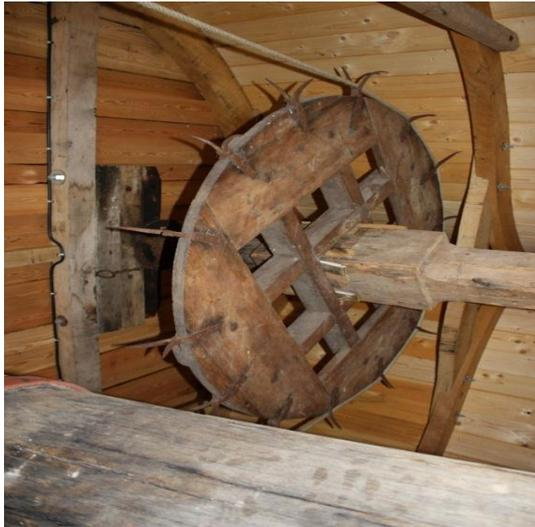
Das Kamrad oder Asrad treibt auch eine **Sackwinde** an, mit der die Kornsäcke auf den **Steinboden (Steinsöller)** außen am Gebäude (**Balkon und Kuckuck**) gehievt werden.
